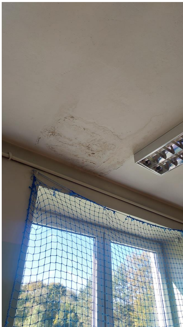
Rys. 5.7 Widok przecieków na stropodachu hali gimnastycznej.
