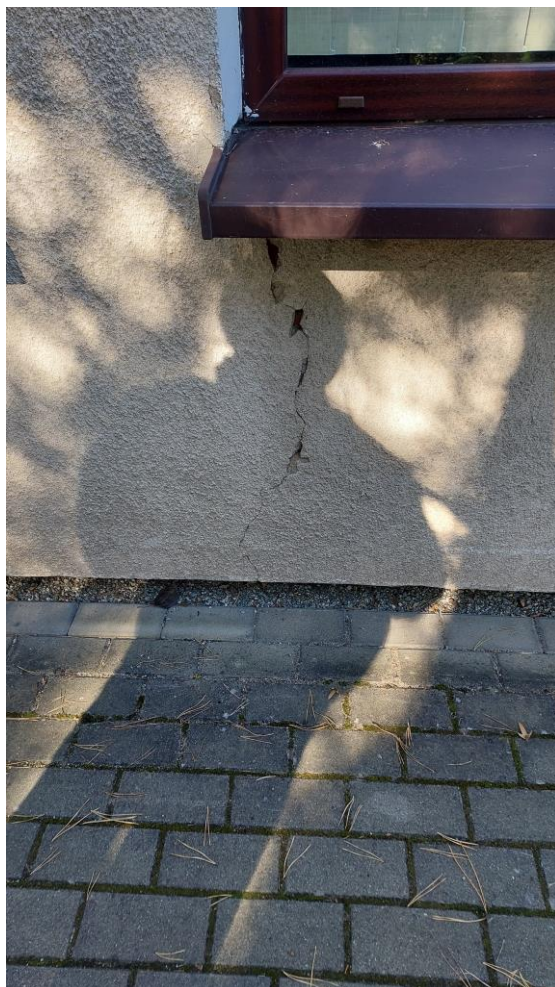
Rys. 5.5 Widok uszkodzenia w strefie podokiennej.
